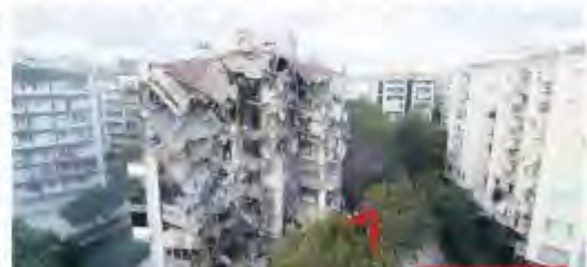
Son on yıllık depremlerden etkilenen bir bölgede yıkılan bir binanın enkazı. Depremden sonra yapılan çalışmaların hızlandırılması gerekiyor.
